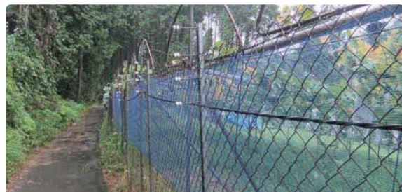
侵入防止柵の設置
