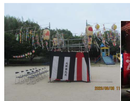
建築用足場による櫓
