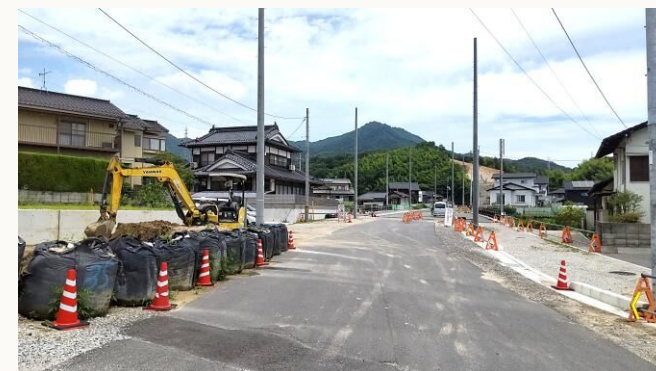
整備の進む市道堂垣内広池山線
