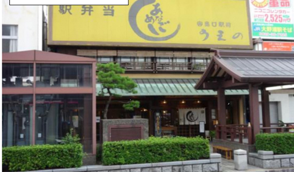
看板除却・修景前
