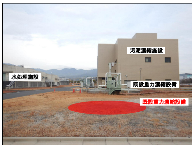
廿日市浄化センター重力濃縮設備の増設
