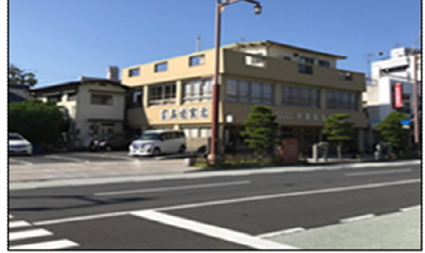
屋上看板除却
