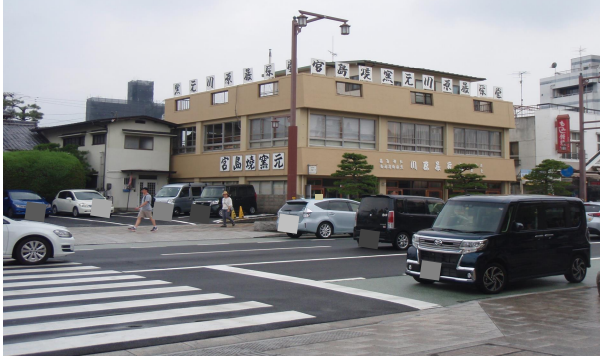
屋上看板除却前
