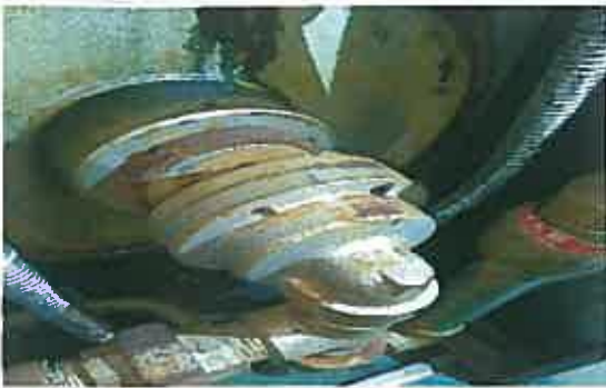
② 蒸気漏れ(スィベルジョイントの緩み) ※C/G釜
