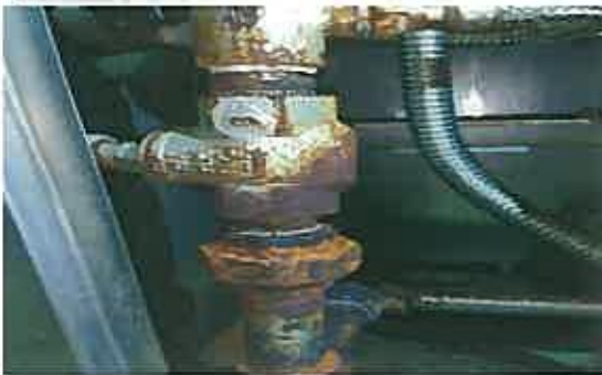
② 蒸気漏れ(給気バルブ下部ユニオン腐食) ※G釜
