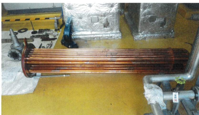
新設加熱コイル外観
