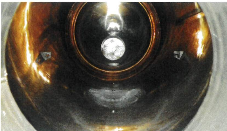
貯湯槽内部点検作業
