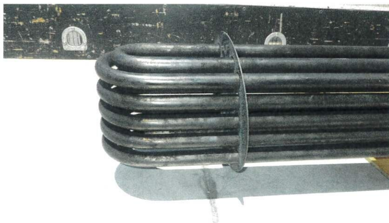
既設. 蒸気コイル 拡大写真
