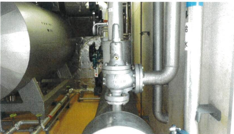
蒸気側. 安全弁外観
