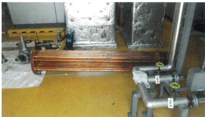
新設蒸気加熱コイル
