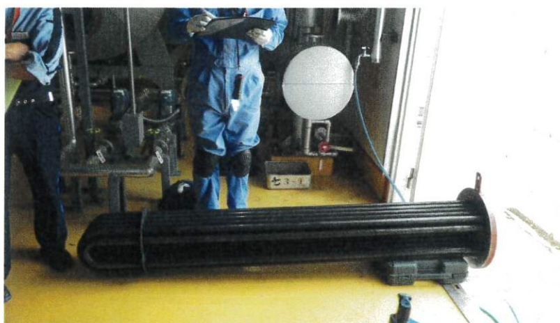
蒸気加熱コイル 水室部、消耗劣化あり 経過観察要す
