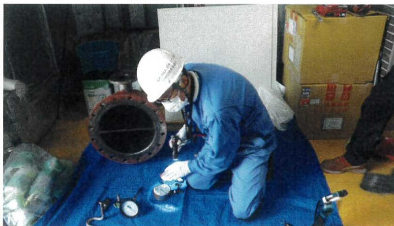
付属部品. 点検風景 圧力計. 温度計類
