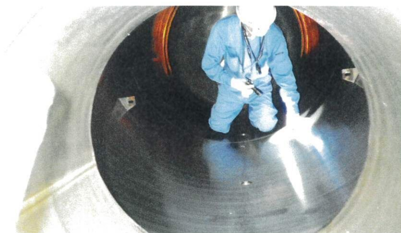
貯湯槽. 内部 性能検査. 受検風景
