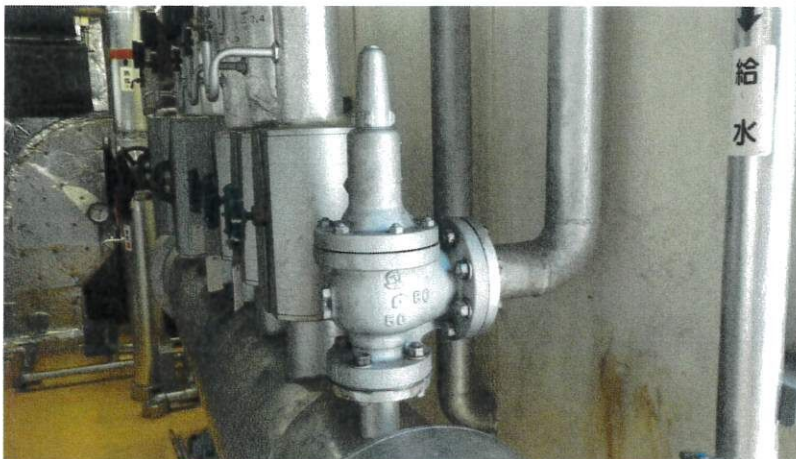
蒸気側.安全弁
