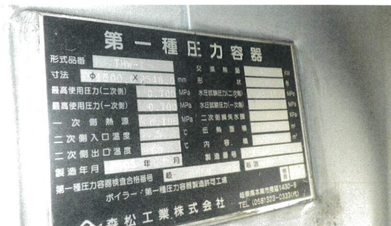
貯湯槽. 銘板 森松工業【株】製品 型式.品番THW-1 製造年月2005年9月
