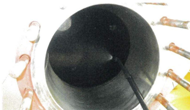
次亜塩素酸ナトリウム溶液 散布作業. 貯湯槽. 内部消毒作業実 施
