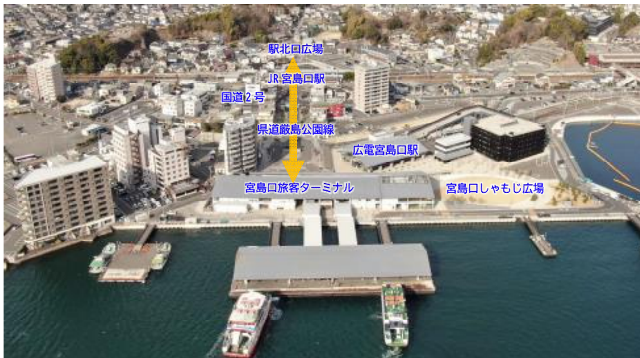
航空写真：広島県撮影（令和 7 年 1 月 31 日）
