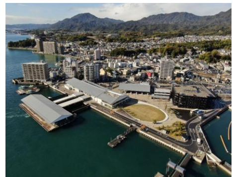
厳島港宮島口地区の整備（広島県提供）
