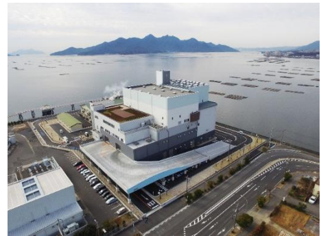
一般廃棄物処理施設 (はつかいちエネルギークリーンセンター)
