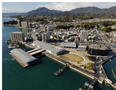
厳島港宮島口地区の整備（広島県提供）
