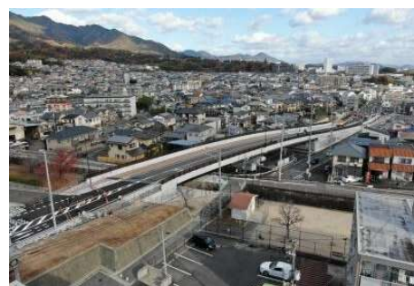
広域道路ネットワークの強化につながる(都)畑口寺田線の整備
