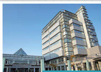
廿日市市役所本庁舎
