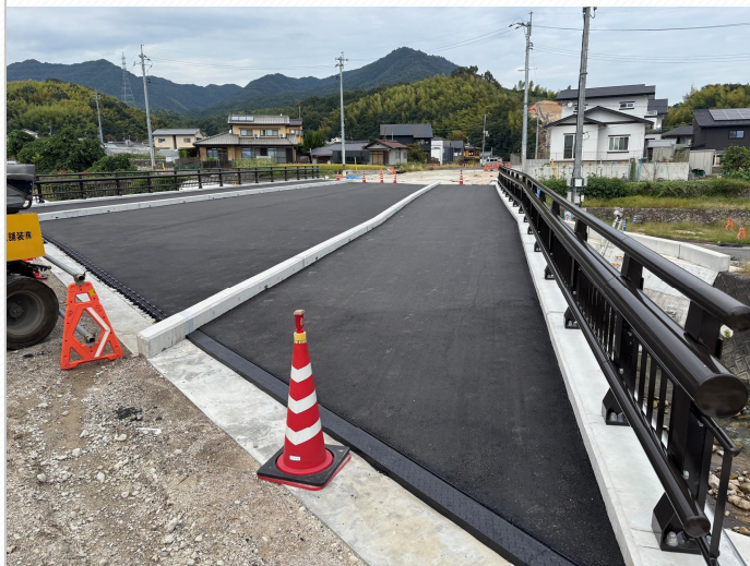
▲堂垣内広池山線郡塚橋
