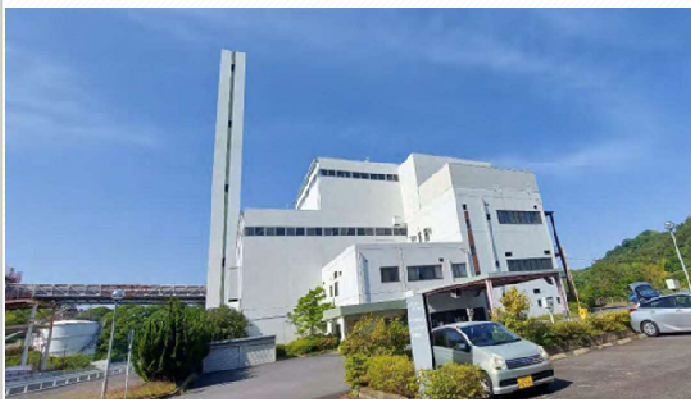
▲解体する旧廿日市市清掃センターの外観
