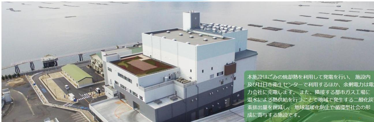
本施設はごみの焼却熱を利用して発電を行い、施設内及び廿日市衛生センターで利用するほか、余剰電力は電力会社に売電します。また、隣接する都市ガス工場に温水による熱供給を行うことで地域で発生する二酸化炭素排出量を削減し、地球温暖化防止や循環型社会の形成に寄与する施設です。
