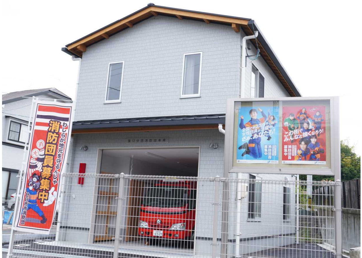
新築移転した第12分団第1部（宮島口）車庫
