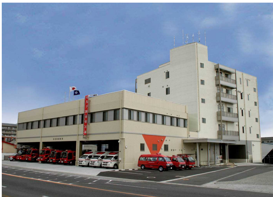
消防本部・廿日市消防署
