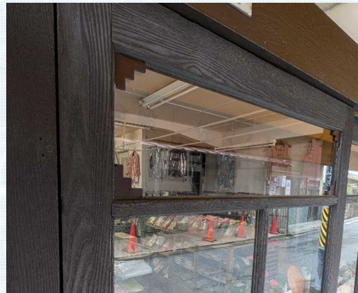
木製建具と波打ちガラス
