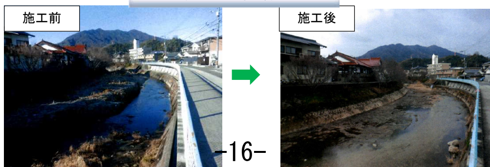
河川しゅんせつ工事（御手洗川）
