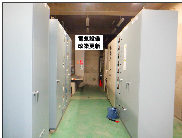
扇ポンプ場電気設備の改築更新工事
