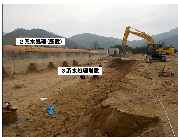
大野浄化センター3系水処理の増設工事
