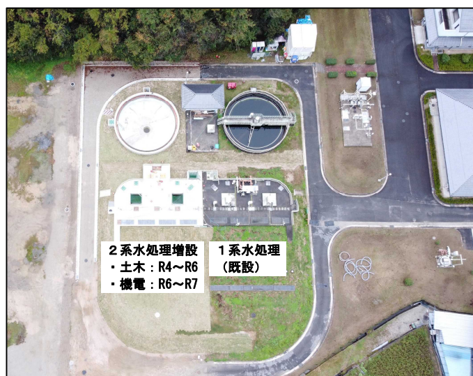
友和浄化センター 2 系水処理施設の増設工事
