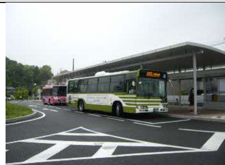
図 49 廿日市市役所前駅の状況
