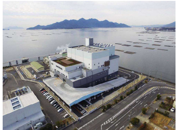
写真 はつかいちエネルギークリーンセンター
