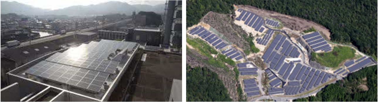
写真 左）市役所本庁舎の太陽光パネル 右）大野太陽光発電所
