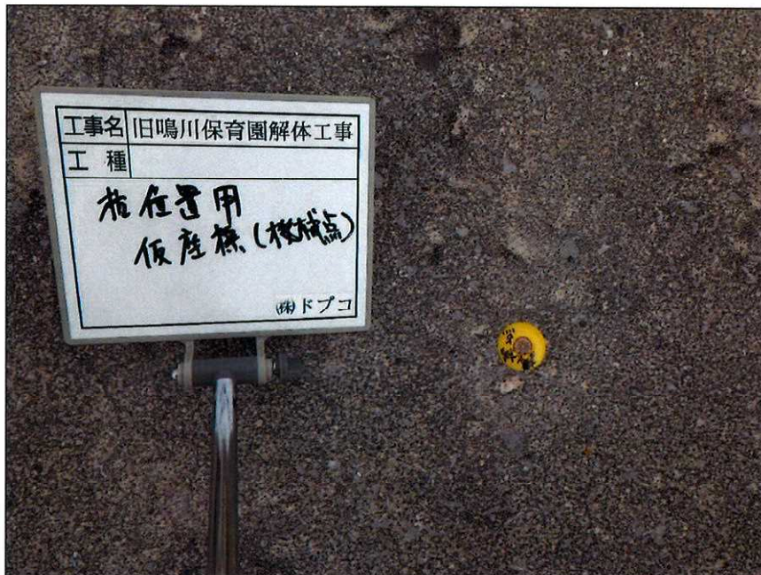
旧鳴川保育園解体工事 施工状況写真 杭頭処理 仮座標(機械点、後視点) 機械点 拡大確認
