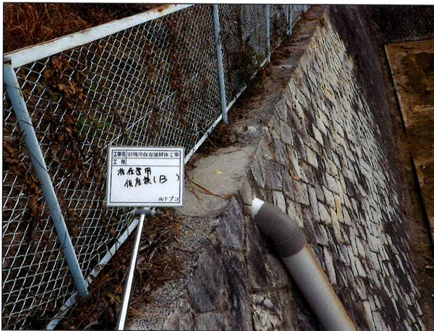
旧鳴川保育園解体工事 施工状況写真 杭頭処理 仮座標(機械点、後視点) 後視点
