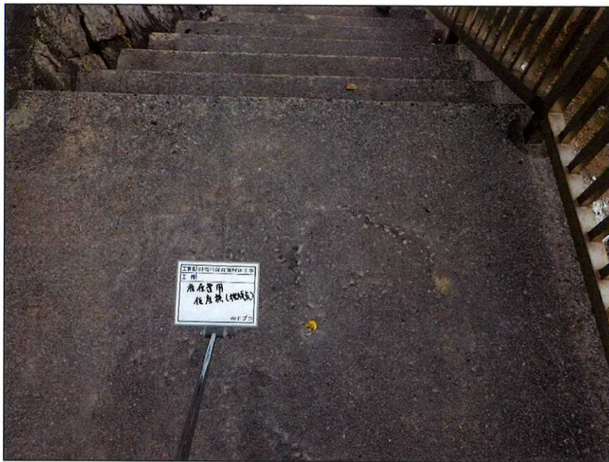
旧鳴川保育園解体工事 施工状況写真 杭頭処理 仮座標(機械点、後視点) 機械点
