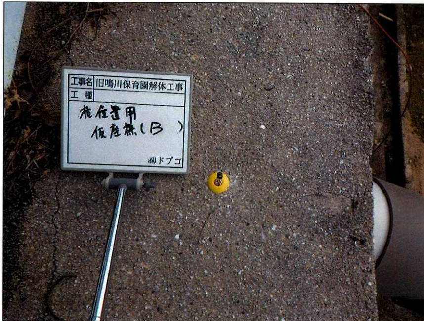
旧鳴川保育園解体工事 施工状況写真 杭頭処理 仮座標(機械点、後視点) 後視点 拡大確認
