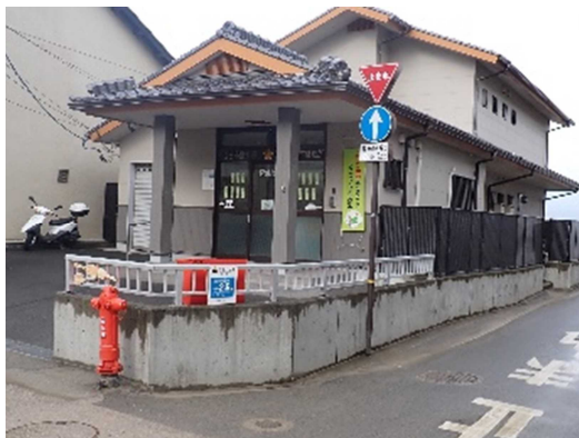
道路標識と消火栓
