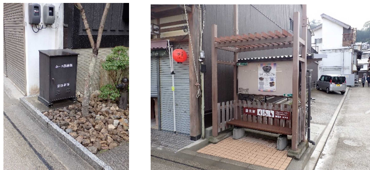
色調の統一が図られたホース格納庫・休憩スペース
