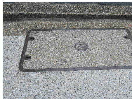
舗装同材のマンホール
