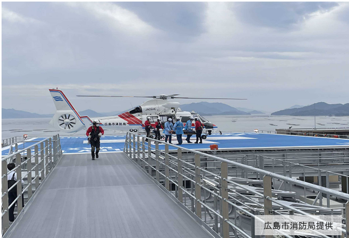
ＪＡ広島総合病院南棟 ヘリポート
