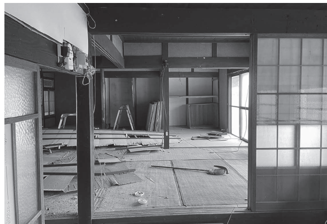
▲古くなった壁や畳を剥がし、改修を進めた
