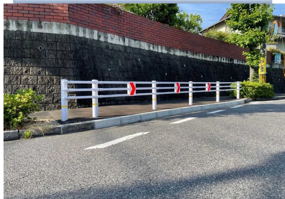
防護柵設置工事の例（四季が丘9-1号線）
