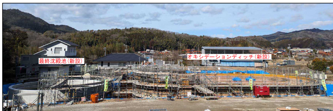
友和浄化センター2系水処理施設の増設工事
