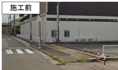
段差解消工事の例（扇園2号線）
