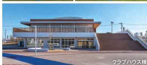
クラブハウス棟
