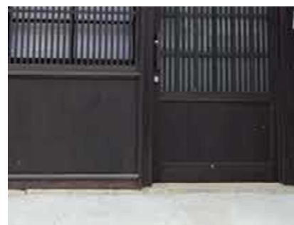
宮島の石を用いている様子
