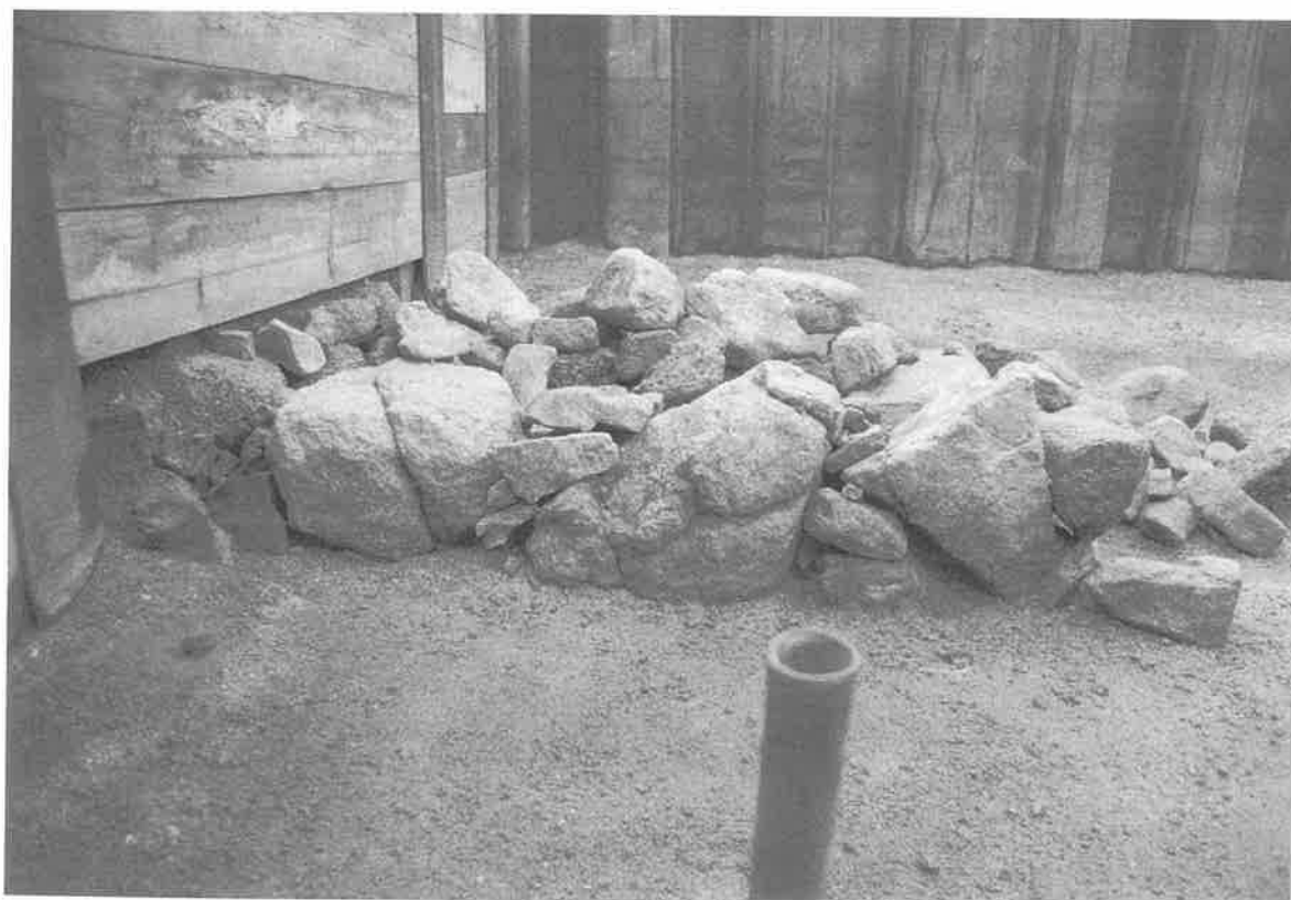
調査区東端部石垣状況（北から）
