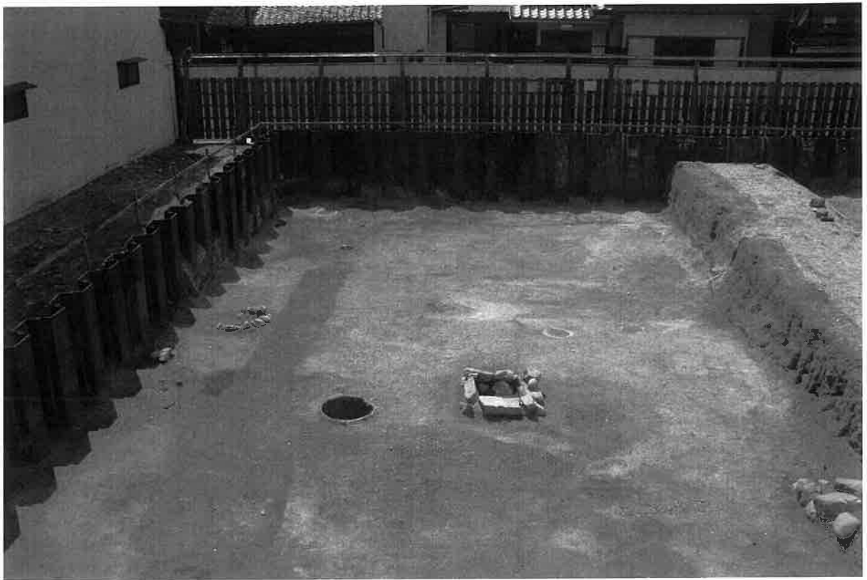
近世～近代遺構検出状況 南区（東から）
