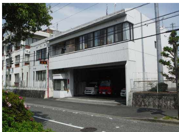
廿日市消防署西分署
