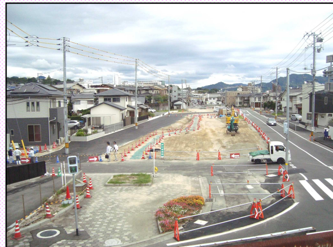
仮設道路完成時 (令和元年9月撮影)
