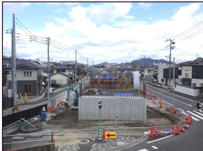
橋梁下部工施工時 (令和2年1月撮影)
