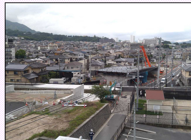
橋梁上部工施工時 (令和2年8月撮影)
