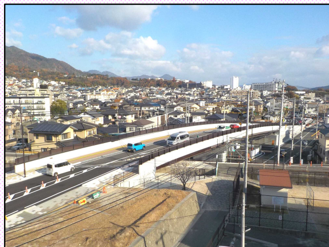
畑口寺田線開通時 (令和3年12月撮影)
