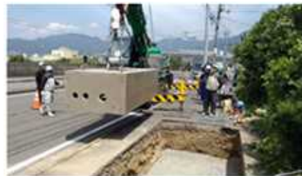
自営線の埋設工事状況
