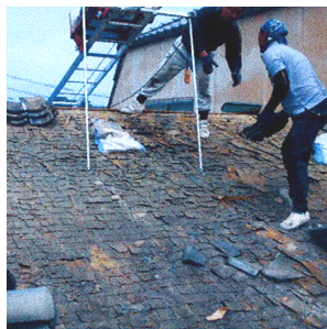
屋根解体時の そぎいた 粉板下地
