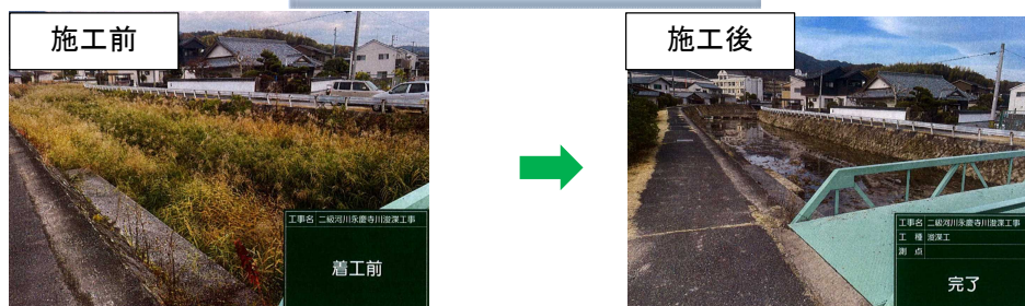
河川しゅんせつ工事（永慶寺川）
