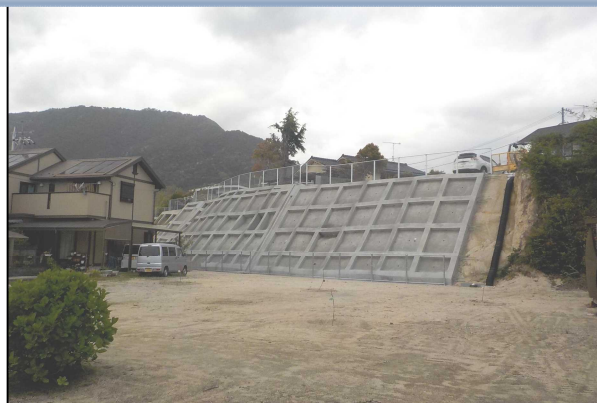
急傾斜地崩壊対策工事の例（丸石地区）【継続事業】
