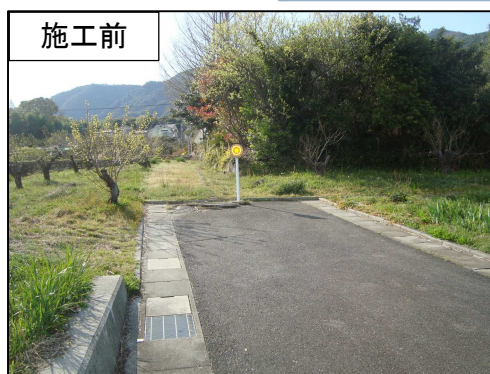
道路改良工事の例 (市道丸石10号線)
