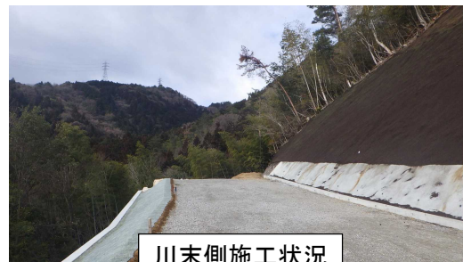
川末側施工状況
