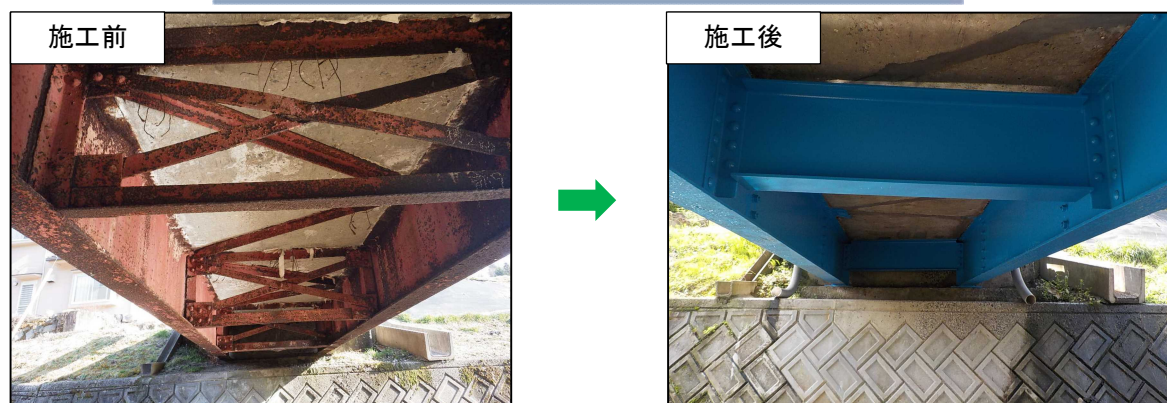
橋りょうの長寿命化工事の例（市道兼康線（兼康橋））
