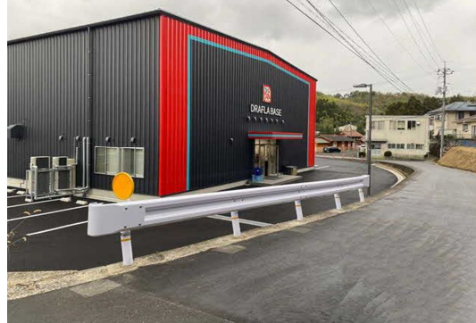
ガードレール設置工事の例（土居線）
