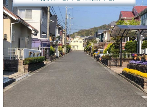
大規模住宅団地（宮園団地）
