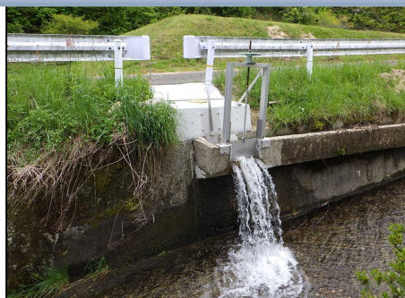
農業用水路の整備の例（玖島地区ゲート）
