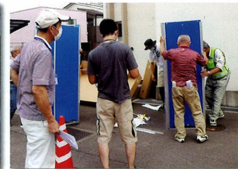
設営中のマンホールトイレ
