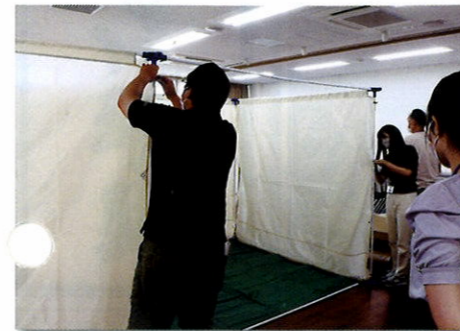
設営中の避難所
