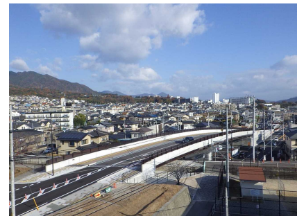
・新佐方大橋 L=68m(RC 橋)
