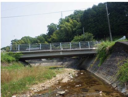
・河津原橋 L=19.5m(RC 橋)
