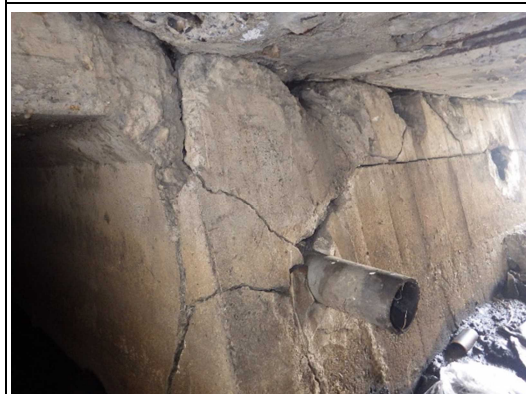
橋台の損傷
