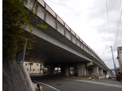
・七尾陸橋 L=83m(RC 橋)
