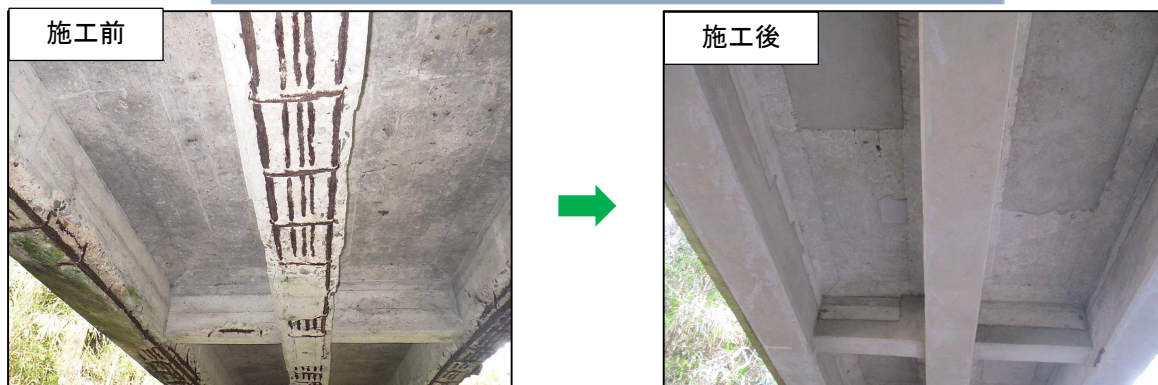
橋りょうの長寿命化工事の例（林道池の谷線（丈ノ口橋））
