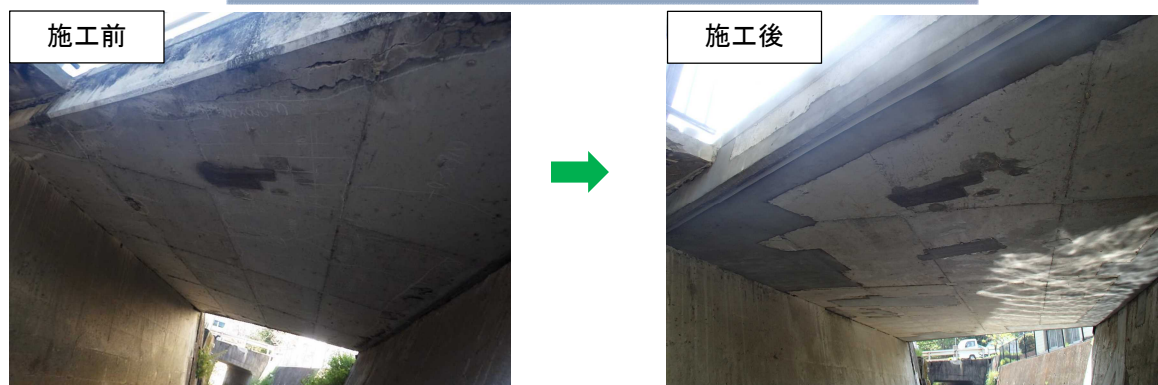
橋りょうの長寿命化工事の例（更地2号橋）
