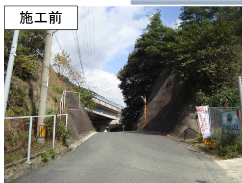
道路改良工事の例(滝ノ下清水ヶ峯線)
