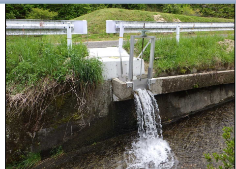
農業用水路の整備の例（玖島地区ゲート）
