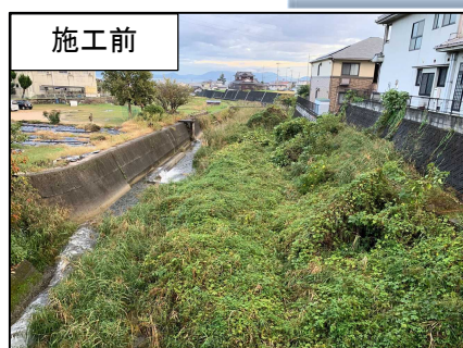
河川しゅんせつ工事（可愛川）
