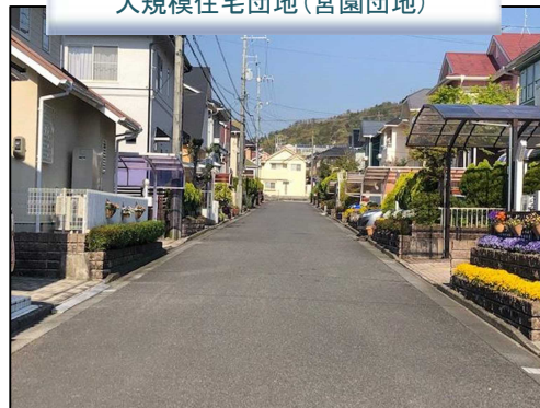
大規模住宅団地（宮園団地）
