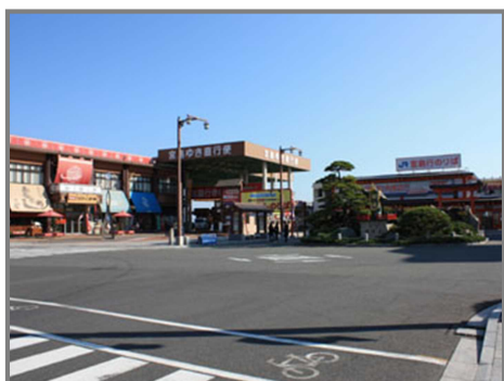
国際的な観光地「宮島」の玄関口としては、必ずしもふさわしくない色彩や規模の建築物や屋外広告物がみられる宮島口
