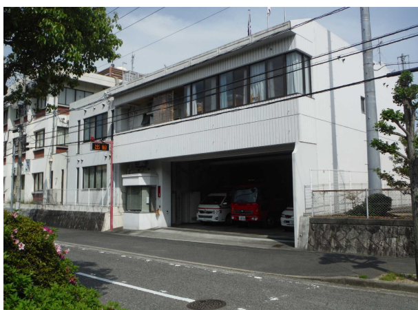
廿日市消防署西分署
