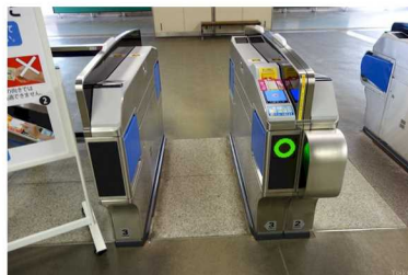
【イメージ写真】 QRコード及び交通系 IC カードを利用した駅務システム（北九州モノレール）
