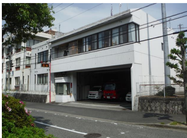
廿日市消防署西分署
