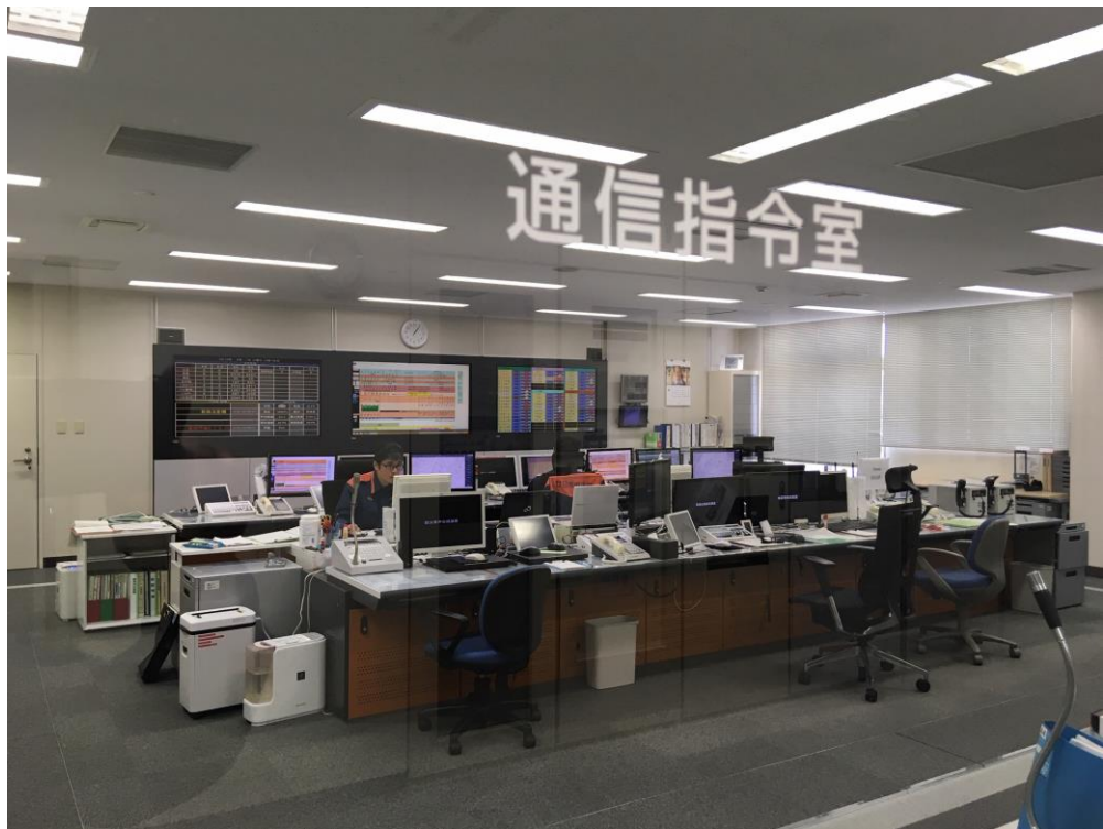
高機能消防指令センター
