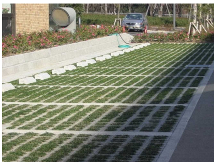
駐車場修景事例(緑化舗装ブロック)
