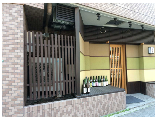
室外機を隠すルーバー
