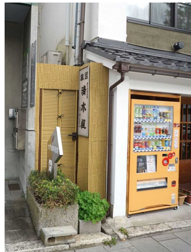
竹垣による建築物のすき間や設備隠し
