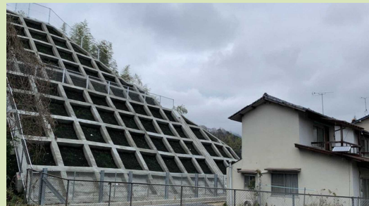
▲対策工事を行った急傾斜地
