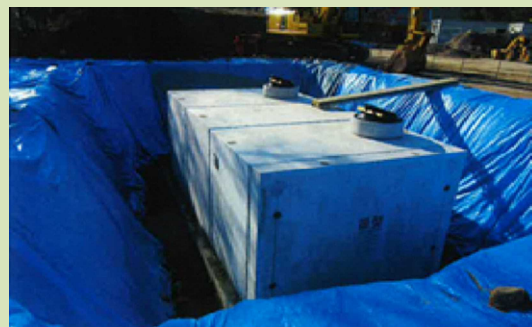
▲防火水槽を整備するようす
