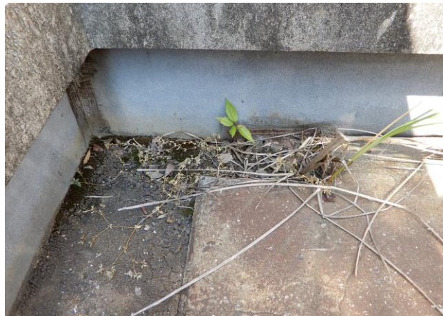
1 3 の位置です。 3階屋上設備機器置場（1）北東角面です。 ドレン廻りに汚泥、枯れ草が堆積しています。
