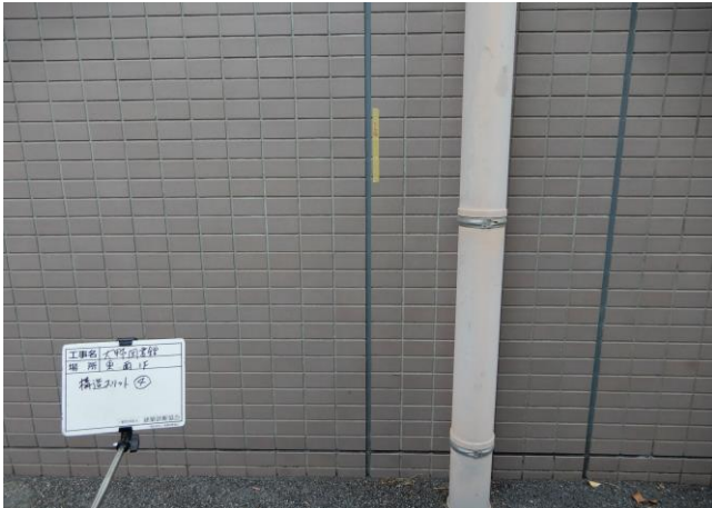
105の位置です。 1階外壁東面壁スリット位置を確認しました。
