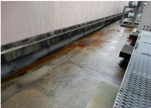
9 8 の位置です。 北側の3階屋上設備機器置場（1）の様子です。 降雨後の状態です。 滞留水が散見され、錆汁が見られます。
