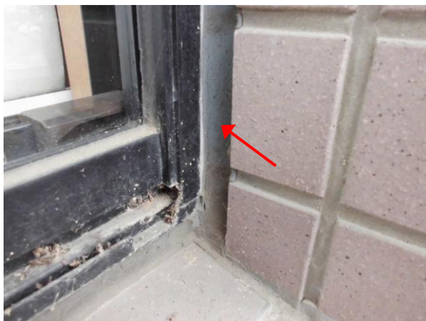
107. 1階 AW-4 福祉コーナー 引違窓 褪色、白錆の発生、シールの劣化して 亀裂が生じていました。
