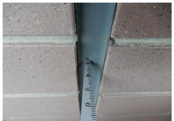
シール厚さは25 mmでした。 符号KW15の壁なので片側25 mmの 切れ込みが必要です。 十分なスリット形状になっています。
