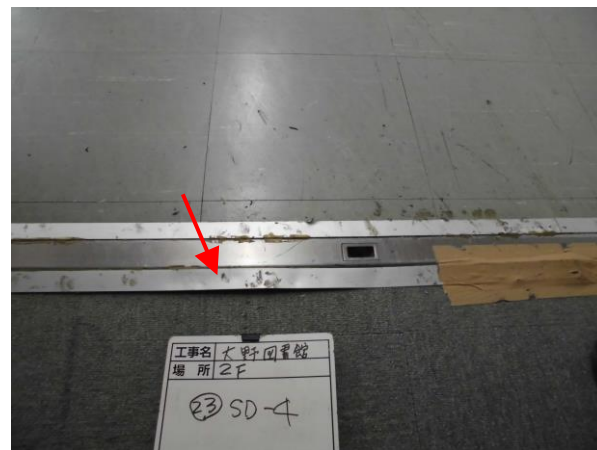
23. 2階 SD-4 両開き扉 段差解消用のアルミ平鋼が変形していました。
