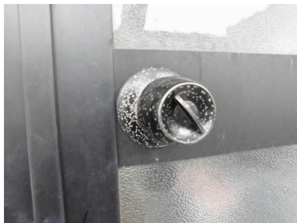
2. 3階ホール AD-3 両開き框扉 ドアノブの塗装が劣化していました。
