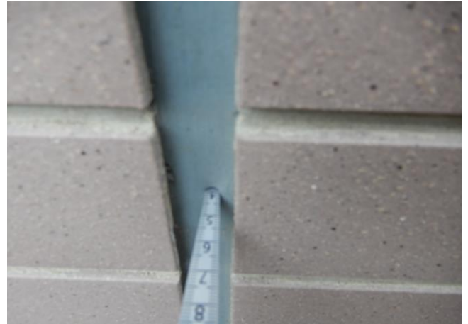
シール厚さは40 mmでした。 符号W15の壁なので片側25 mmの 切れ込みが必要です。 十分なスリット形状になっています。
