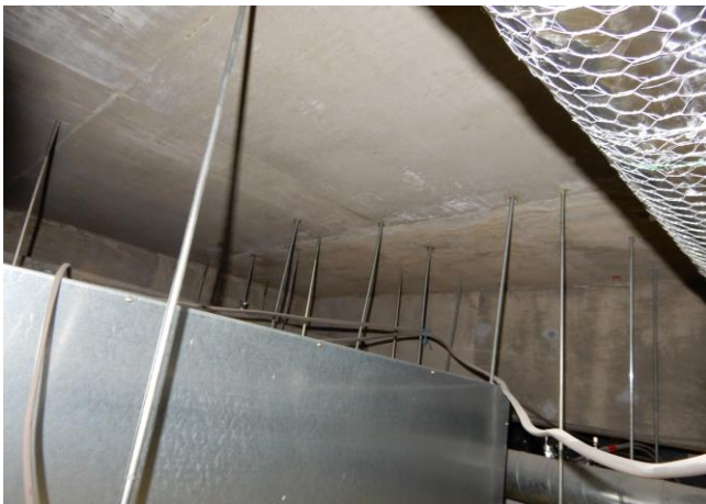
116の位置です。 1階閲覧室中央部廻りの様子です。 梁、天井廻りに漏水、ひび割れ等は 確認できませんでした。
