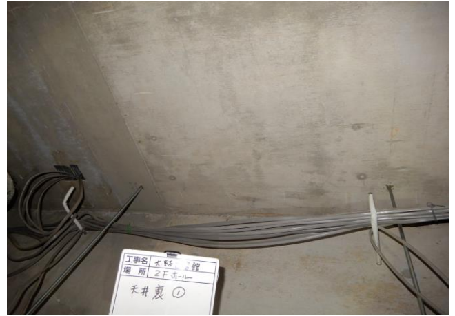
外壁面・スラブの様子です。 漏水跡、ひび割れ等は確認できませんでした。
