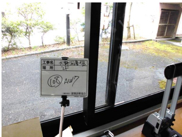
108. 1階 AW-7 事務室 引違窓 開閉作動が不良でした。
