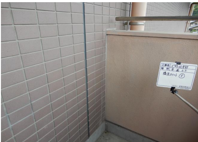
106の位置です。 2階外壁東面壁スリット位置を確認しました。
