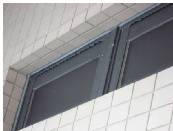
29. 2階 AW-20 排煙窓 退色していました。 隙間塞ぎのゴムがへたっていました。
