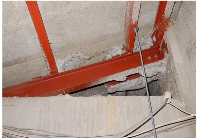
コンクリート打設が途中までで天井までに すき間がみられます。
