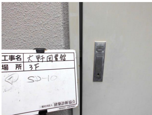
4. 3階屋上 SD-10 片開き扉 平面ハンドルが作動不良でした。
