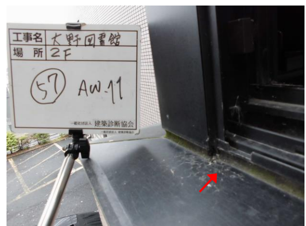
57. 2階 AW-11 引違窓 シールが劣化して亀裂が生じ、苔も生えていました。
