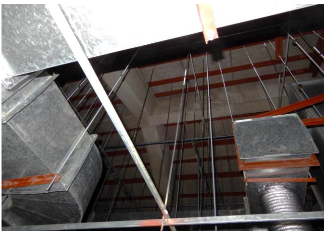
鉄骨、釣りボルト等の錆、天井の漏水跡等は、 確認できませんでした。 躯体梁の様子を確認しましたが、 気になるひび割れ等はありませんでした。
