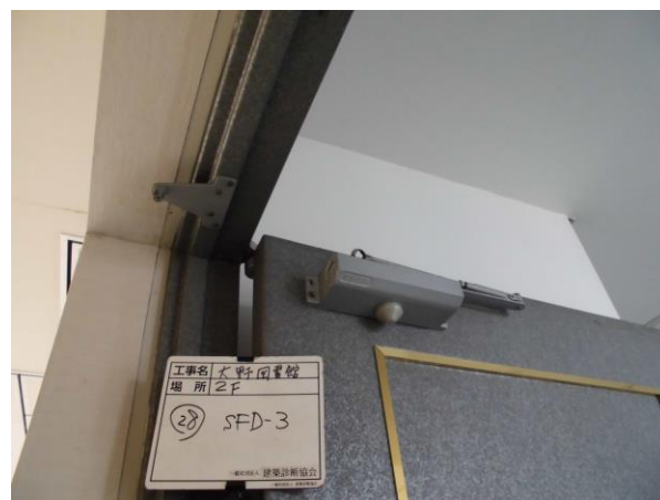
28. 2階 SFD-3 両開き扉 ドアクローザーが故障していました。
