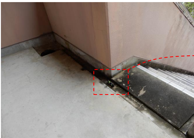
9 9 の位置です。 2階東面開放廊下廻りの様子です。 排水溝の勾配を水平器を使用して確認しました。
