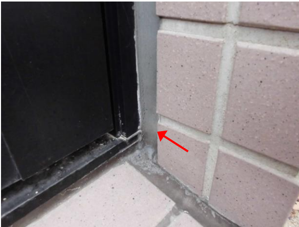
74・75. 1階 AW-15 片開き窓 シールが劣化して亀裂が生じていました。
