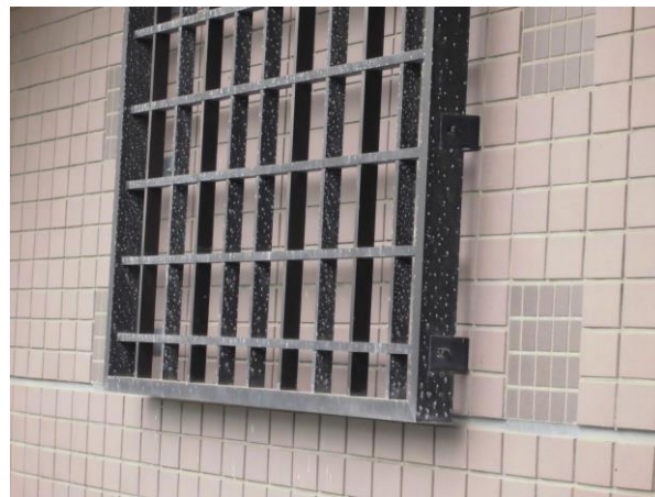
19. 3階外壁 AM-2 アルミ格子 退色と白錆が発生していました。
