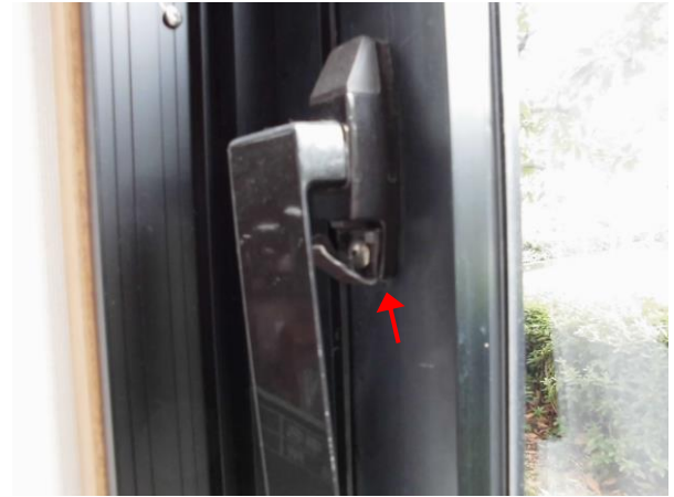
74. 1階 AW-15 片開き窓 ハンドル金物の一部が破損していました。
