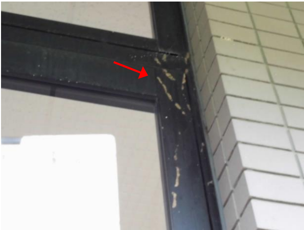
88・92・93・97・98. 1階 AW-15 片開き窓 ツタが完全に除去されずに、 サッシ枠にツタが残っていました。
