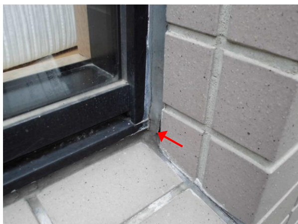
73・81. 1階 AW-2 FIX窓 シールが劣化してまして 亀裂が生じていました。
