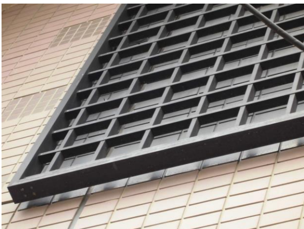
103. 2階 AM-1 アルミ面格子 アルミ部が褪色していました。 白錆が発生していました。
