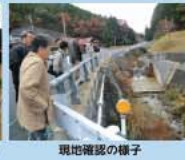
現地確認の様子
