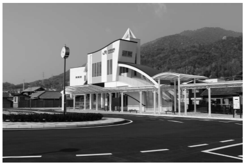
整備が完了し便利になったJR大野浦駅周辺
