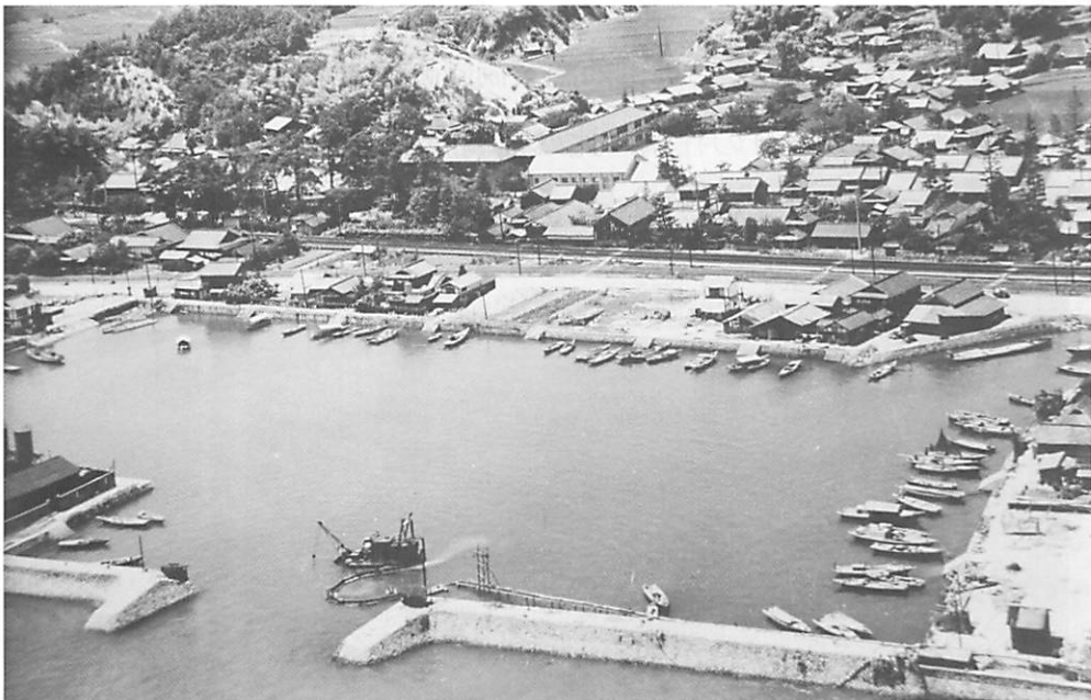
地御前の波止場
