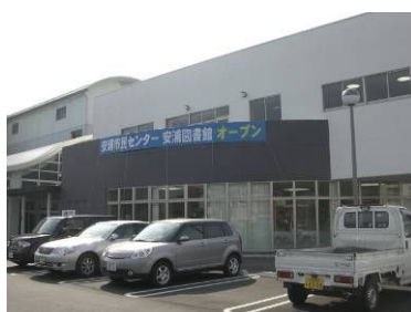
市民センター外観
