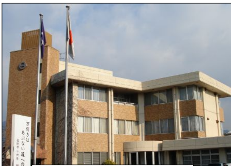
Kushido Community Center・串戸公民館
